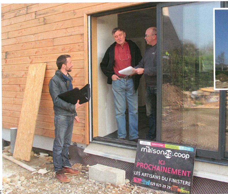
De gauche à droite, Ivan Birel, Paul Denis et Jean-Alain Le Quéré sur le chantier de la maison de Quimper.
